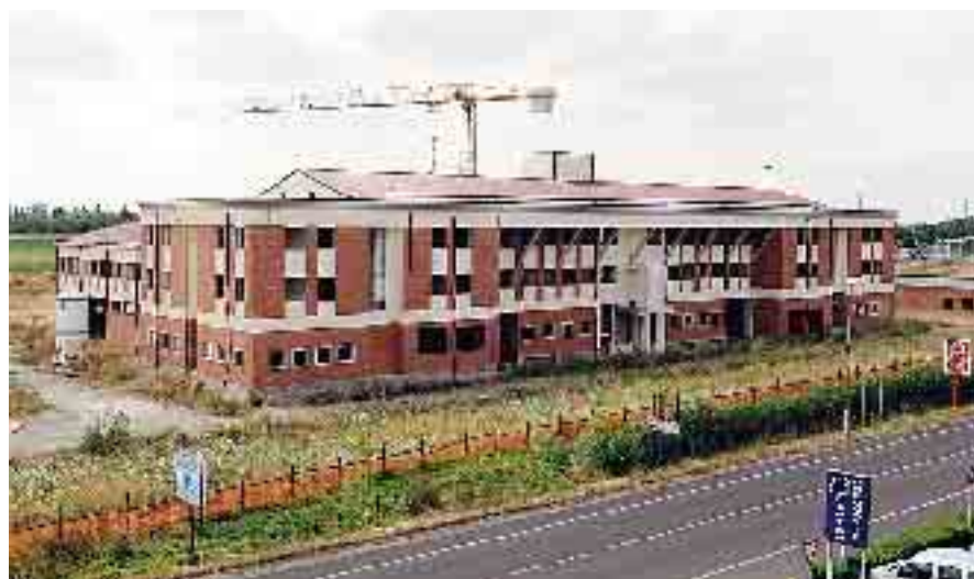
La costruenda nuova sede dei Vigili del Fuoco di Piacenza, lungo la strada Valnure, sarà pronta entro settembre 2011. (foto Bellardo)
